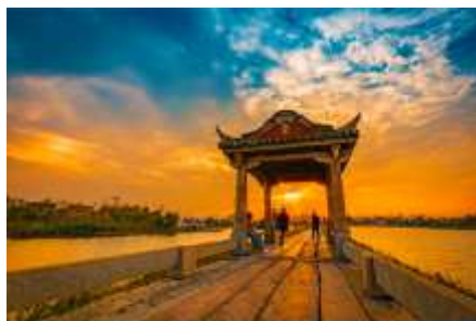
สะพานอันผิง
