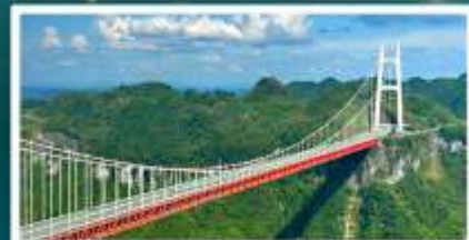
สะพานอ้ายจ้าย
